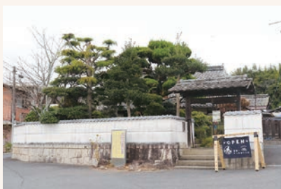
横溝正史疎開宅を山田建設が修繕させていただきました。 (平成26年)
